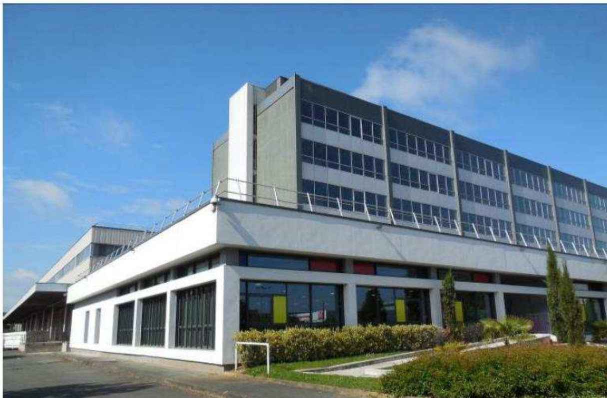
Vue de la façade du bâtiment de bureaux
