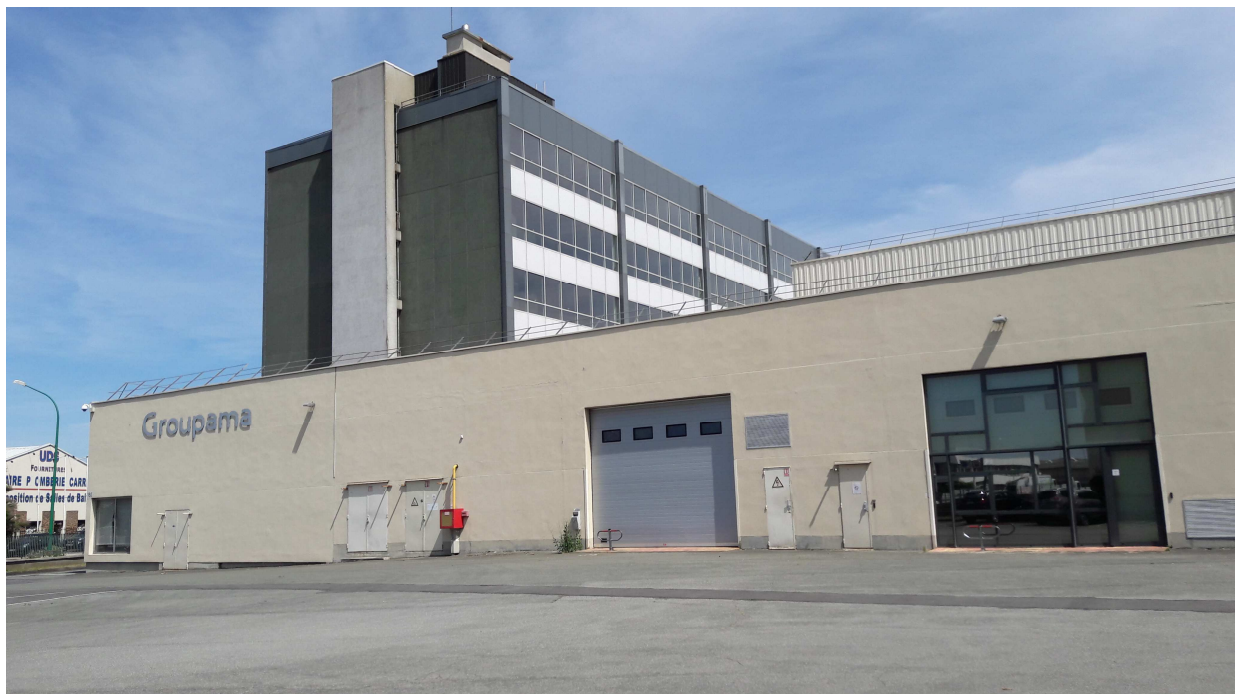
Vue de la façade l'entrepôt (avant)
